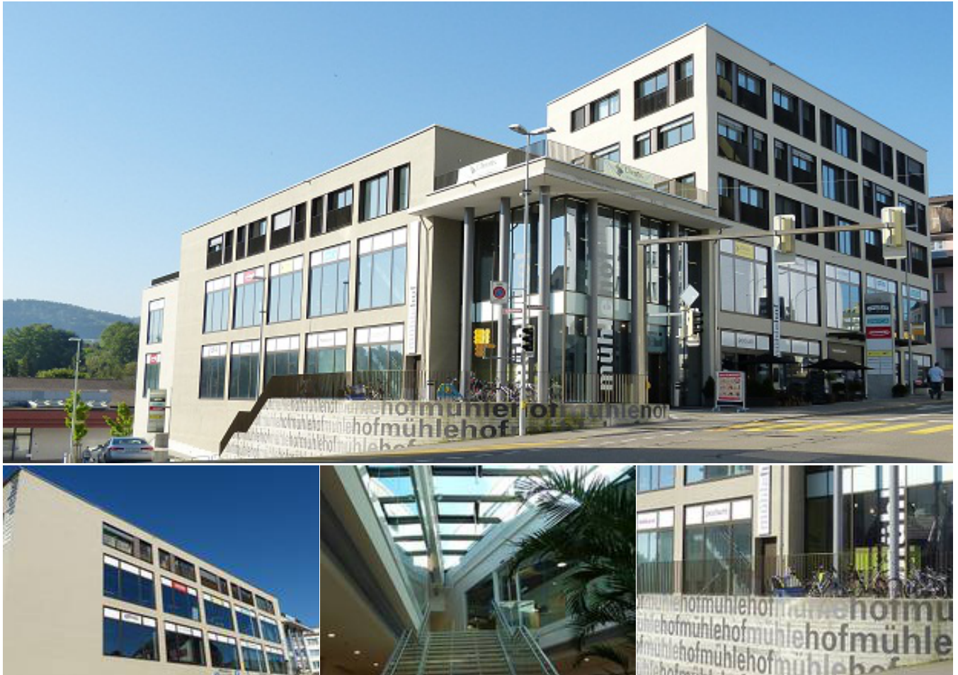
Bürohaus Mühlehof Uzwil, Schweiz
